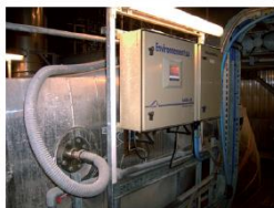
Instalacja bezpośrednio na kominie
